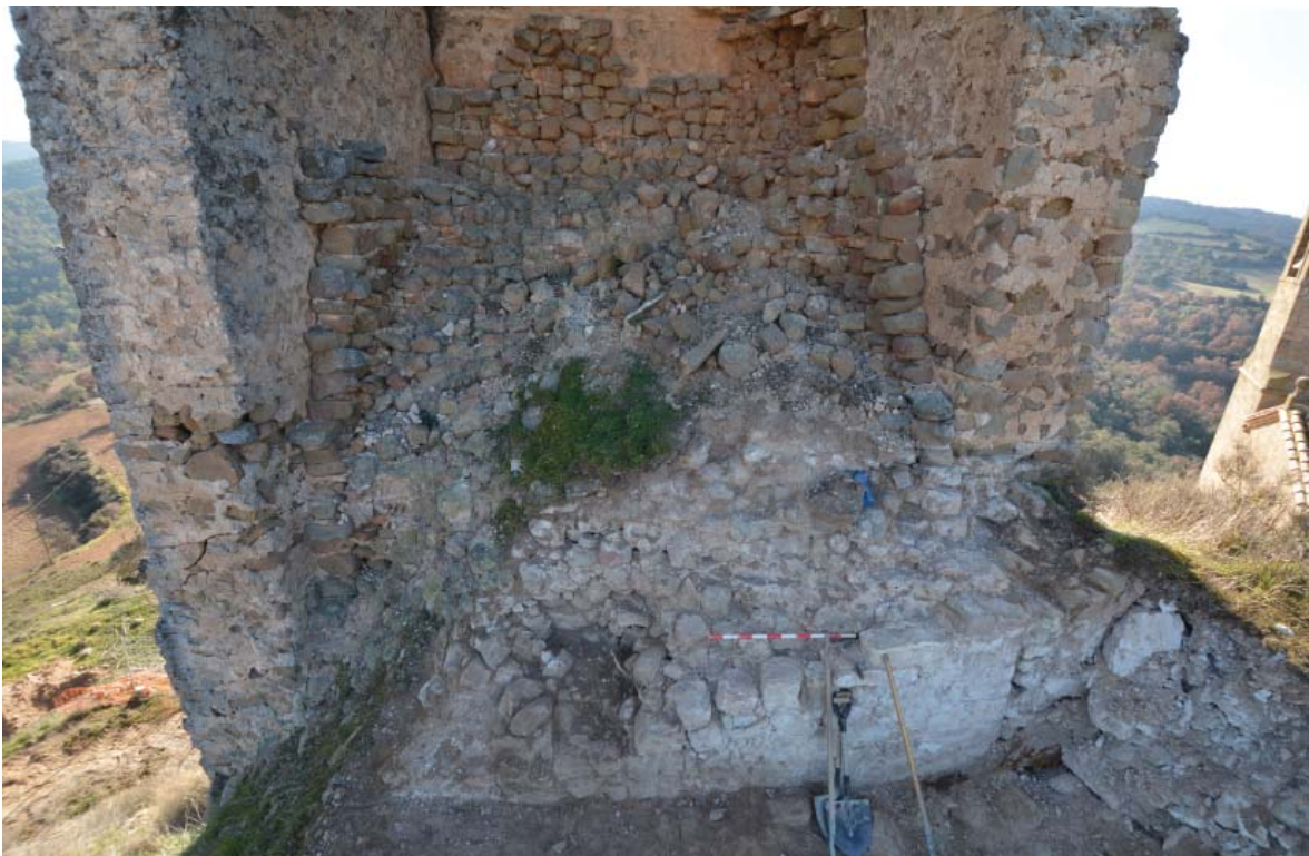
Fig. 57. L'interior de la torre abans de l'excavació de l'enderroc.
