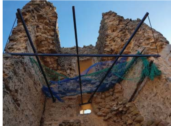
Fig. 28. Instal·lació de la xarxa de seguretat. APP, gener de 2018.
