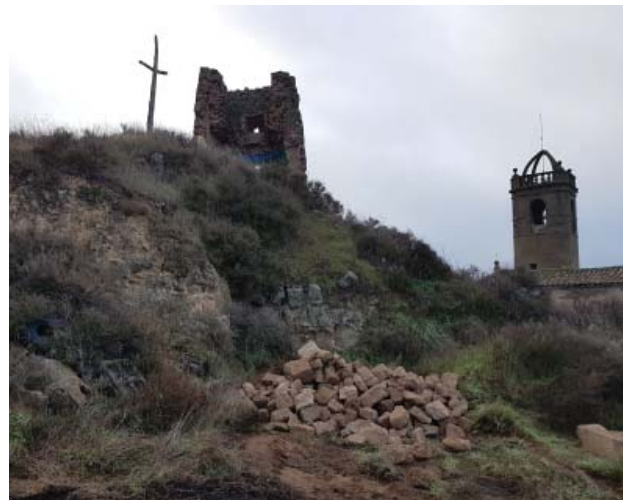
Fig. 30. Tots els blocs de pedra van ser acopiats al nord-oest del turó, per tal de poder-los utilitzar en futures intervencions. APP, gener de 2018.
