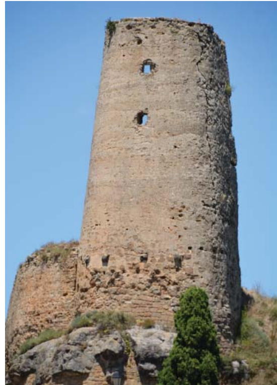
Fig. 16. Parament exterior de la torre. APP, 2020.
