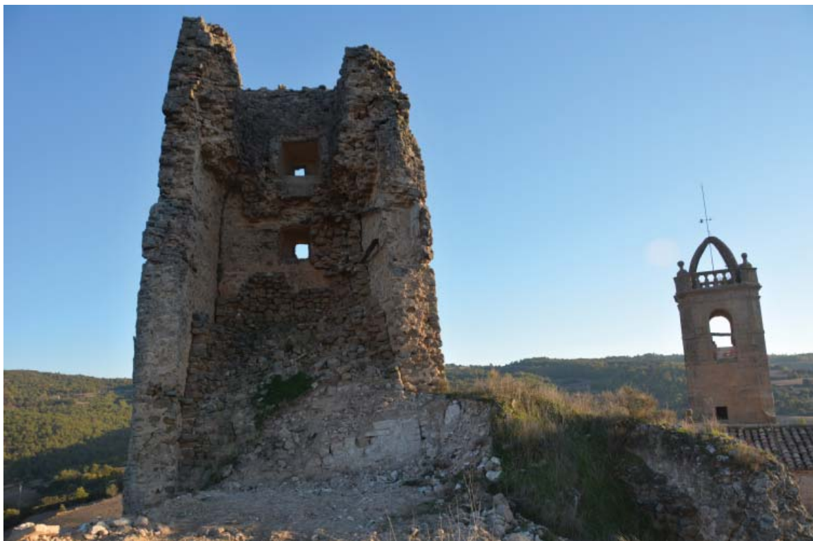
Fig. 17. Vista de l'interior de la torre, abans de l'inici dels treballs, on s'observa l'enderroc que es va excavar en el decurs de la intervenció arqueològica. Foto: APP, desembre de 2017.
