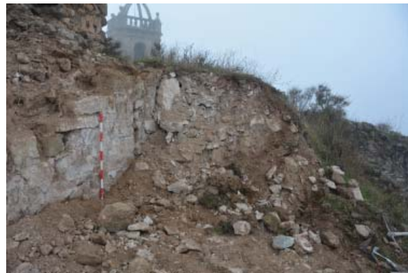
Fig. 26. Vista del sector nord-oest de la torre durant la primera visita a l'obra. Una màquina s'ha obert camí dins al peu de la torre. APP, novembre de 2017.
