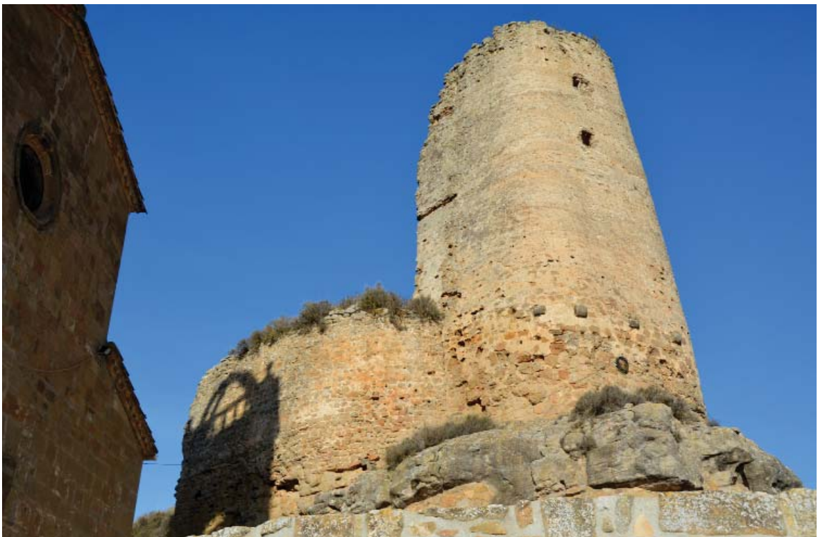
Fig. 8. El parament exterior de la torre des del sud-oest, on també s'observa l'arrancament del perímetre oest del recinte fortificat. Foto: APP, gener 2018.
