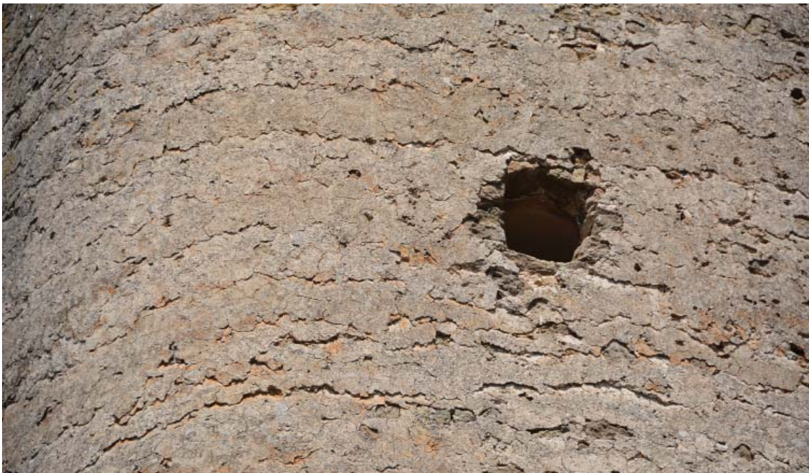
Fig. 18. Detall del lliscat exterior de la torre. APP, 2020.
