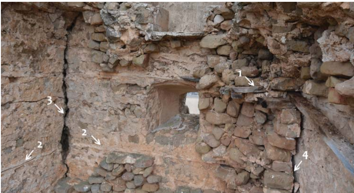
Fig. 13. Detall del llenç interior de la torre exterior a l'altura d'una de les seves finestres, la inferior. A banda dels seus acabats, s'observa es fustes del forjat entre el segon i el tercer pis (1), les empremtes de l'arrebossat original (2), la junta de la cantonada sud-est (3) i la relació en aquest punt, entre els paraments de la torre interior i l'exterior (4). APP, gener de 2018.
