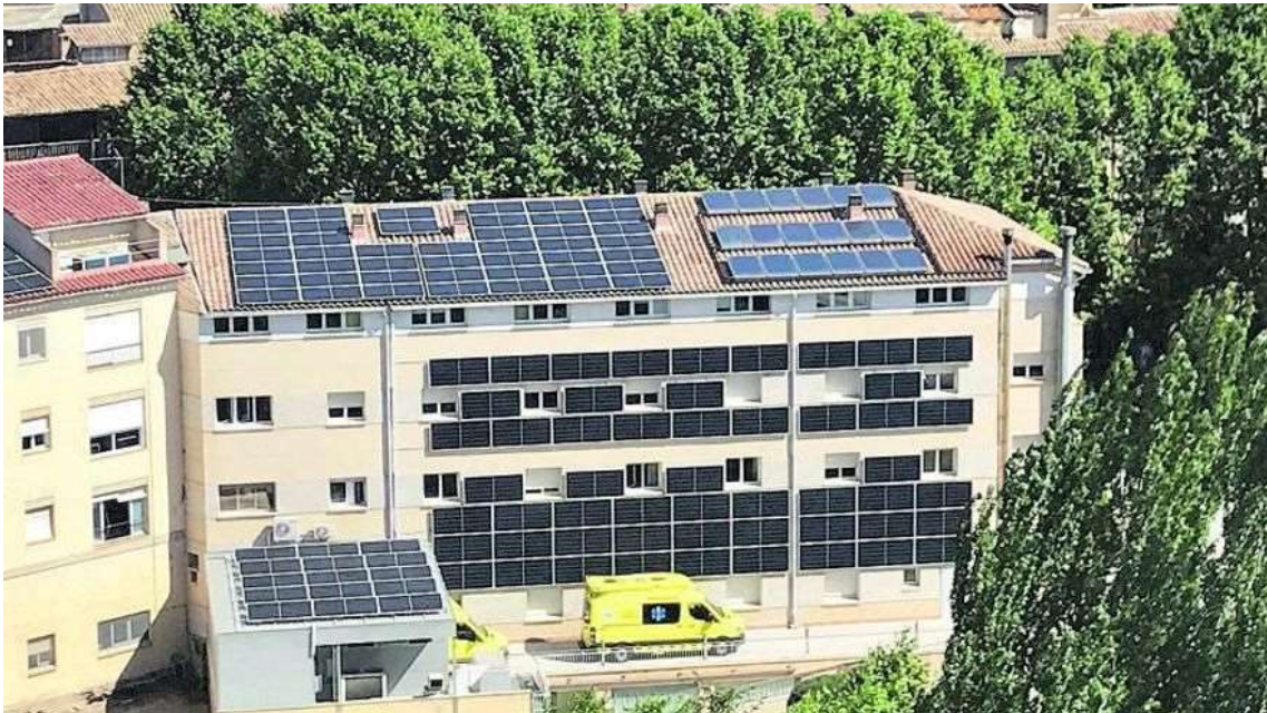
L'edifici del Centre Sanitari del Solsonès amb les 199 plaques solars en funcionament | CC SOLSONÈS
