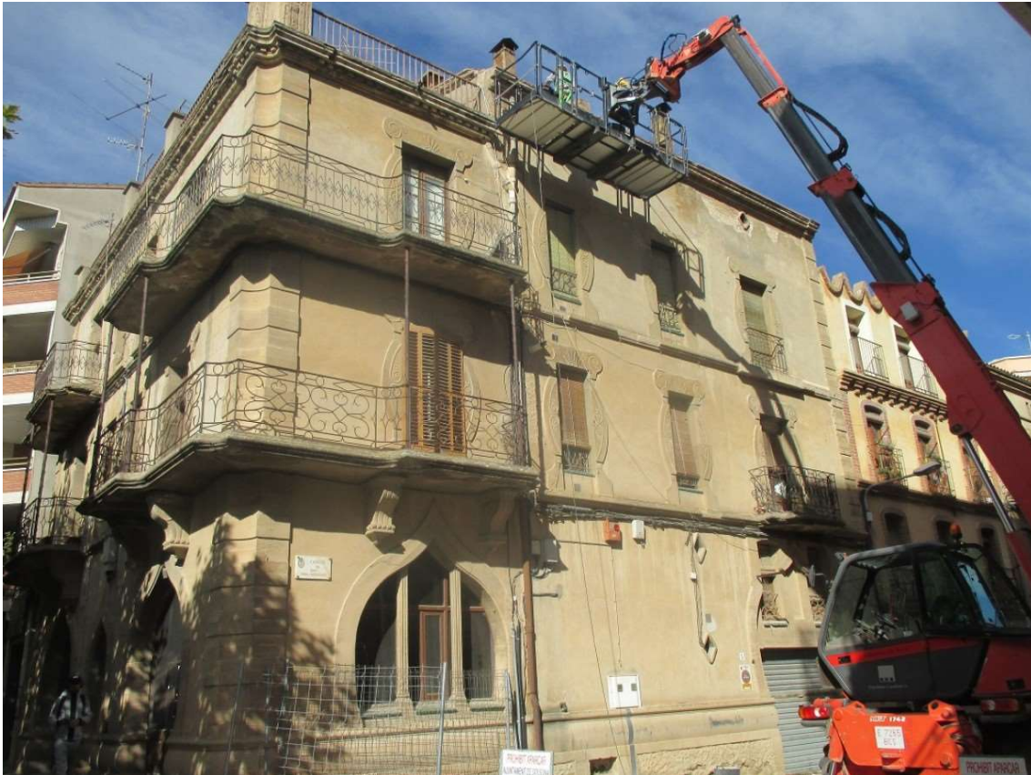
Obres a la façana d'aquesta històrica casa de Solsona | Ramon Estany
