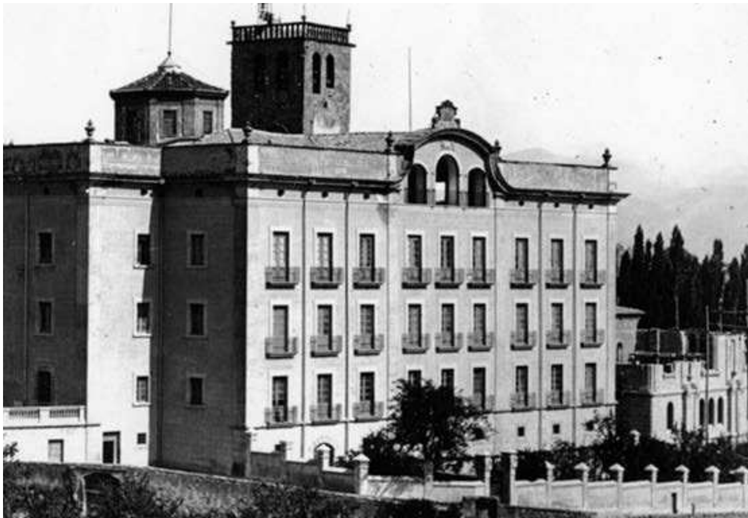
Exterior del cambril en construcció. Imatge corresponent a la primera fase de les obres del Cambril. Encara podem observar l'existència de l'antiga façana ACC
