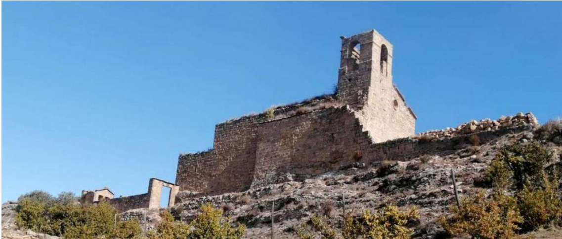
La rehabilitació del conjunt ja està en marxa | ARXIU PARTICULAR
