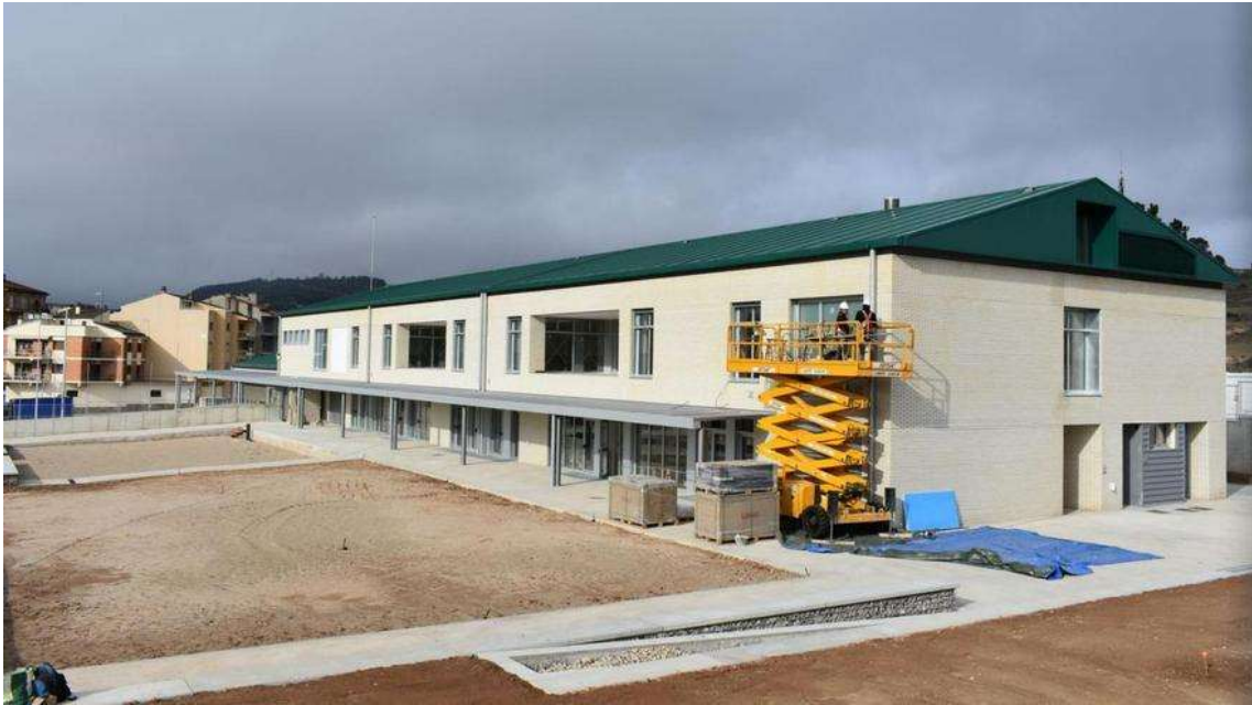
Les obres continuen a l'escola El Vinyet de Solsona | ARNAU VALVERDE
