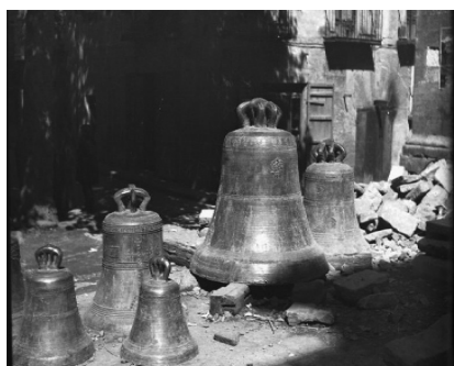
Il·lustració A la dreta: Pont de Solsona ensorrat (1939). A l'esquerre: Les campanes a la plaça de l'Església per fondre durant la Guerra Civil (1936-1939). Autor : Autor: Josep M. Vicens. Font: Arxiu Vicens. Arxiu Comarcal del Solsonès. (CAT ACS 47 2299)
