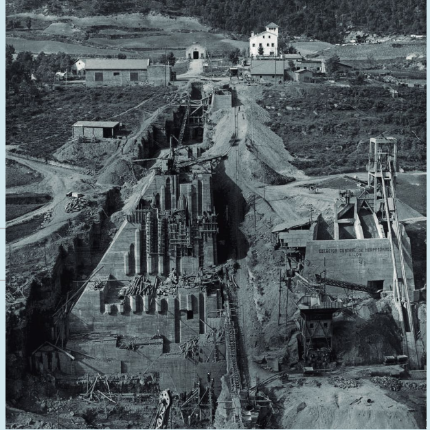
Sant Ponç en construcció
