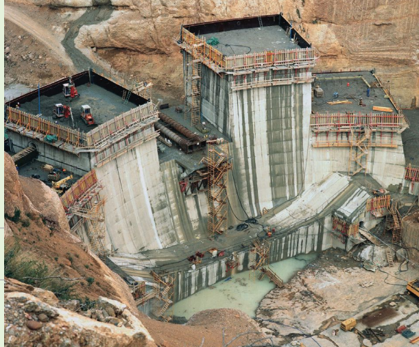
La Llosa del Cavall en construcció
