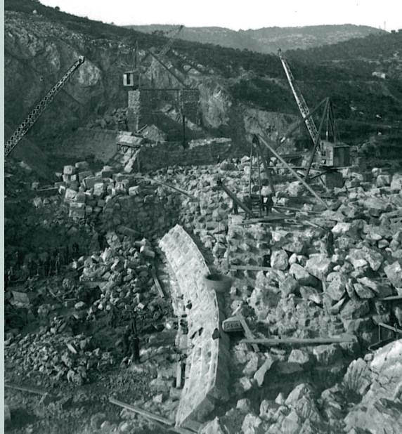
La presa del Foix en construcció
