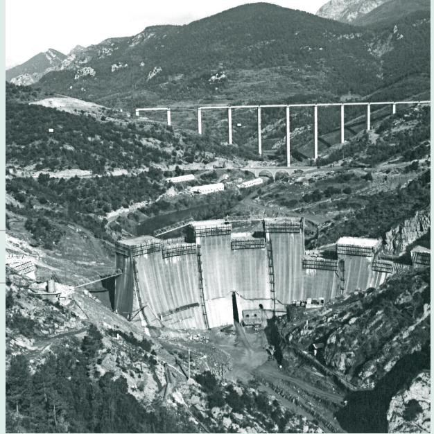
La Baells en construcció
