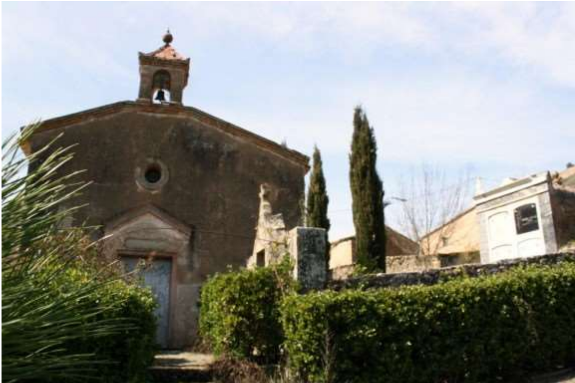
Façana. Antonio Mora
