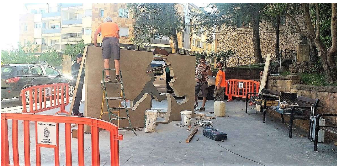
Detall dels treballs d'instal·lació del tòtem Foto: Ramon Estany
