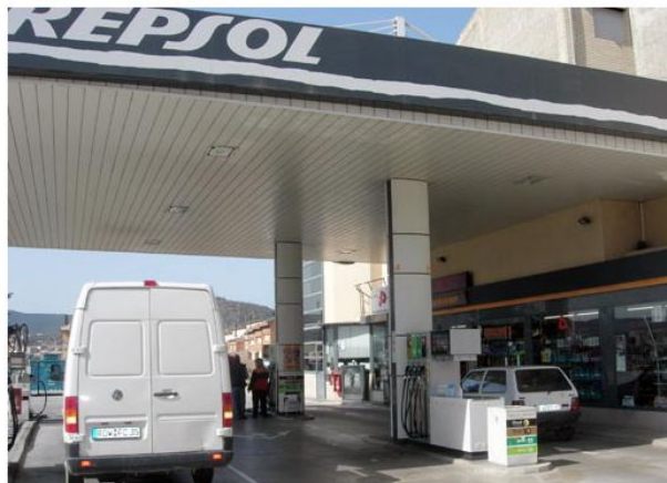
Fotografia actual de l'estació de servei Setelsis
