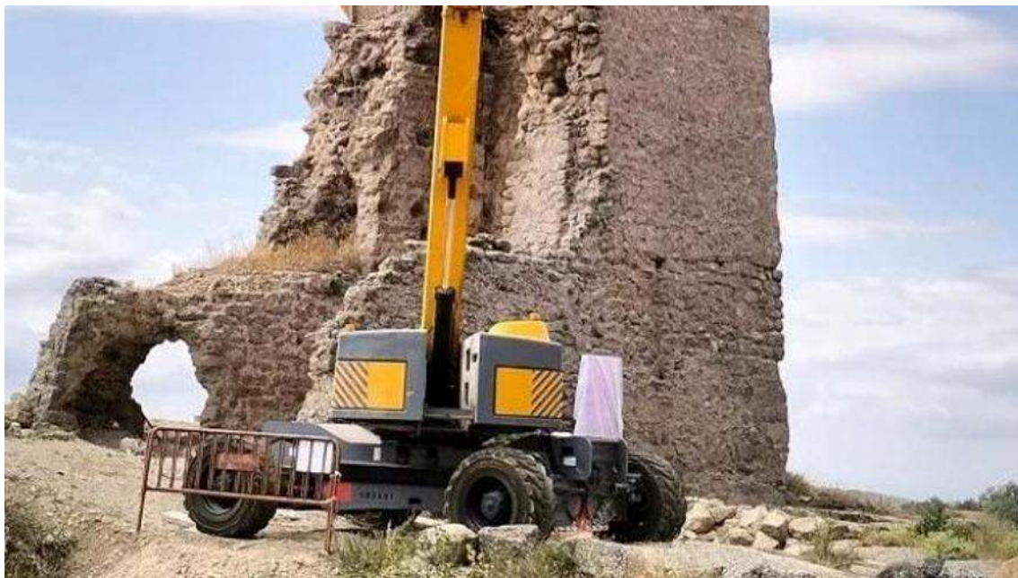
Inici de les obres a la Torre de Peracamps de Llobera AJ LLOBERA
