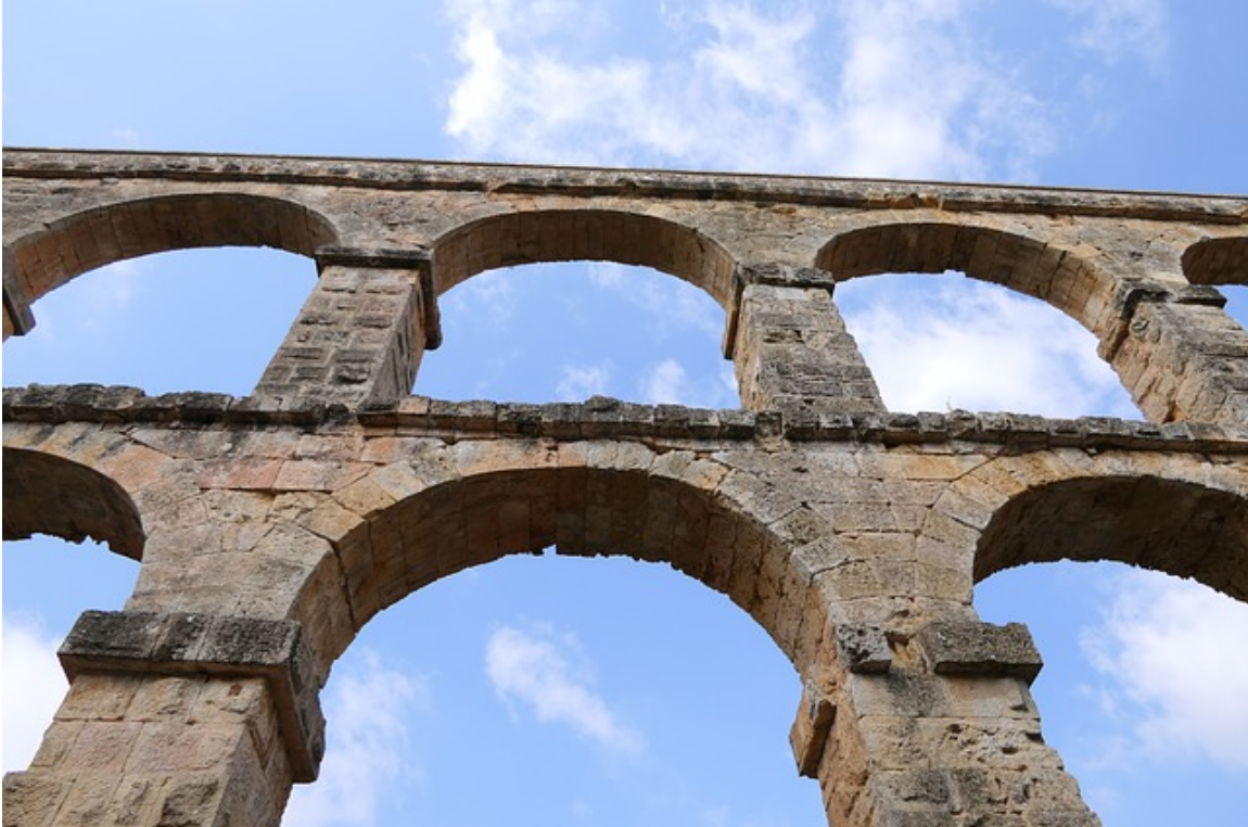
Aqüeducte de les Ferreres – Pont del Diable de Tarragona
