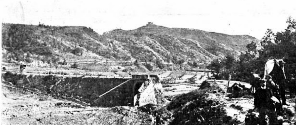
CARRETERA DE CALAF A PONS Y SEU D'URGELL. PONT SOBRE EL BERGÓS DEL QUE'N FOU ARRENCAT EL TERRAPLÉ DEL COSTAT, FENT QUE S'ANEGUessin Y DESTRUISSIN ELS CAMPS Y VINYES DE TORÀ
