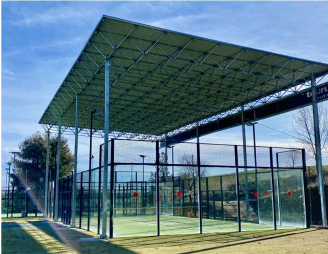
Pista de pàdel coberta
